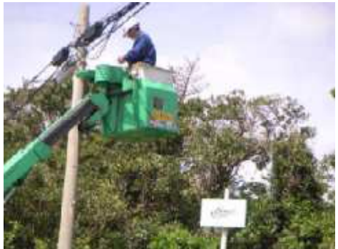
島内は今、光ケーブル工事の真っ最中
